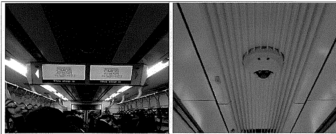
[그림-1] 객실 내 CCTV 카메라 설치 사진
